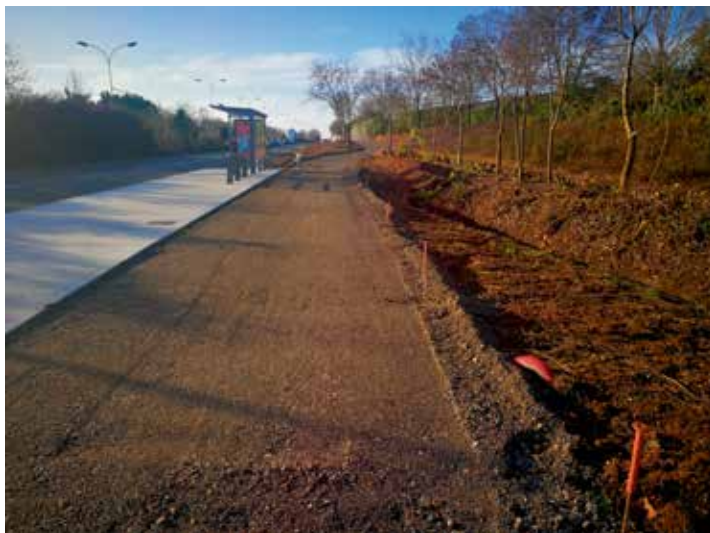
La piste cyclable de l'avenue du 8 mai 1945 en construction...
